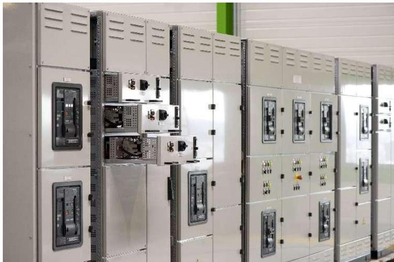
*Fig I.6 tableaux BT d'une installation*
