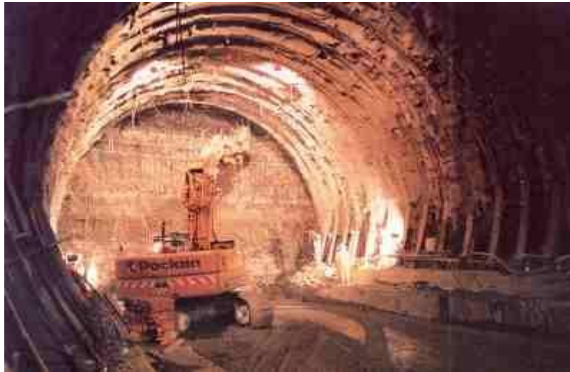
Figure II-10 : Creusement en pleine section
