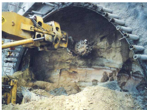
Figure II-9 : Machine à abattage ponctuelle
