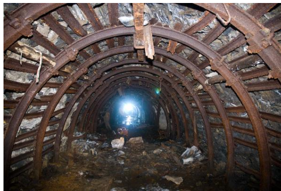
Figure II-13 : Cintres métalliques
