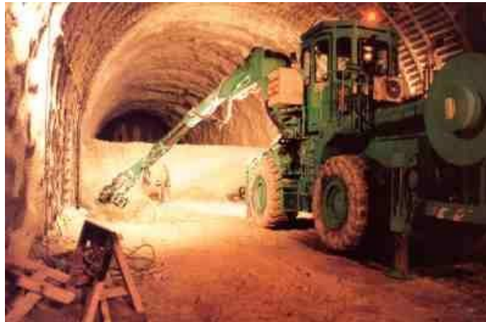
Figure II-11 : creusement par demi-section
