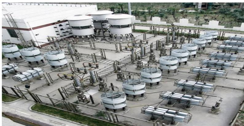
**Figure (II.4) :** Photo montrant une des Plates-formes de SVC [52].
