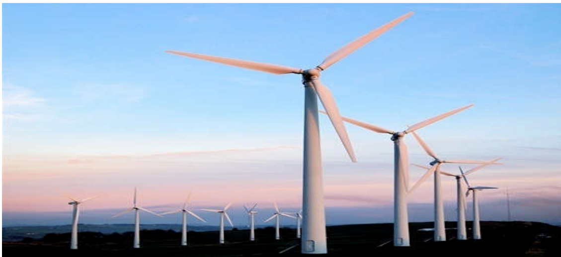
Fig. (I-14) : Ferme d'éolienne
