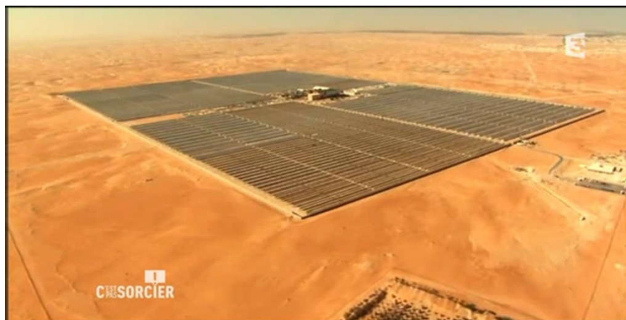
Fig. (I-23): Centrale CHAMS d'Abu Dhabi
