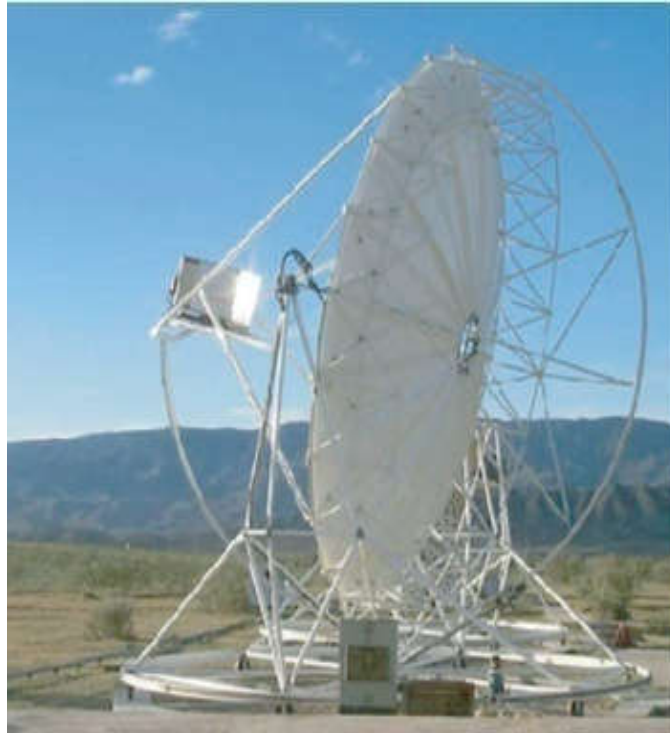
Fig. (I-25): Prototypé préindustriel Eurodish, 10 kW e , construit par SBP-SOLO
