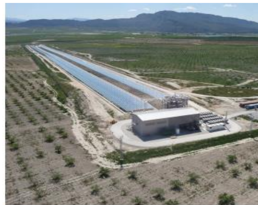
Capteurs linéaires de Fresnel : Centrale Novatec Biosol[27]
