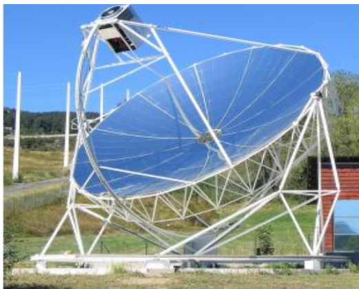
Concentrateurs paraboliques : Projet DISH-STIRLING à Odeillo [27]
