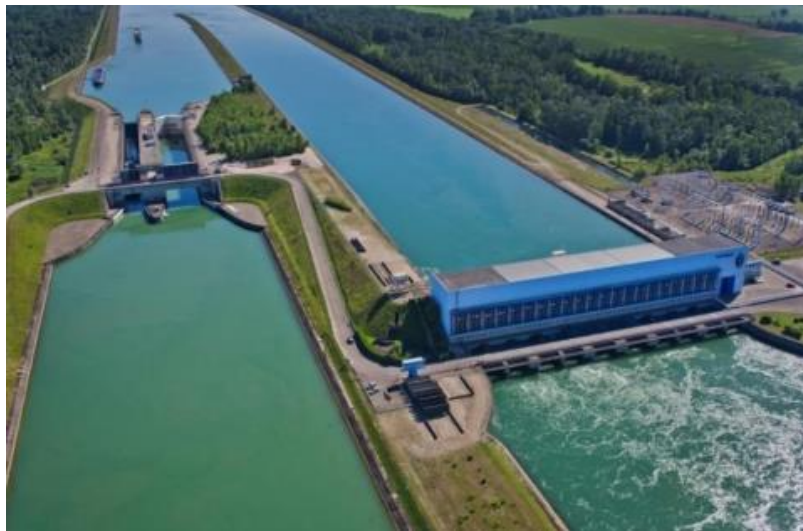
Figure I.18 : Centrale hydroélectrique au fil de l'eau [52]
