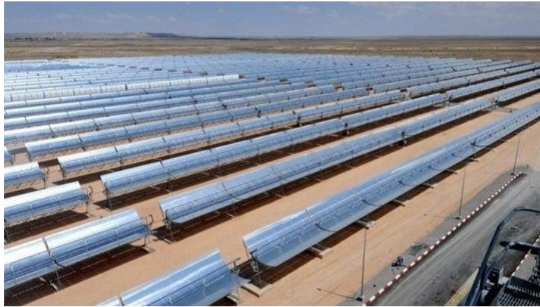
Figure I.7: centrale à Capteurs cylindro-paraboliques (La Station de production électrique « El-Kheneg ») [26]
