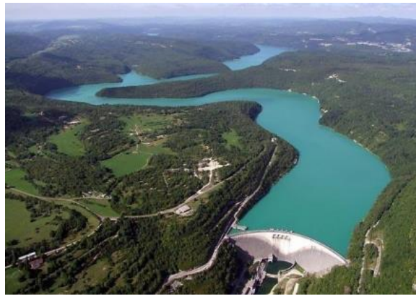
Figure 1.19 : Centrale hydroélectrique au moyenne chute[48]
