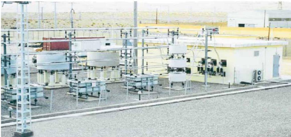
**Figure IV. 21 :** Photo montrant l'une des Plates-formes de ces trois SVCs en Algérie [ABB-01].
