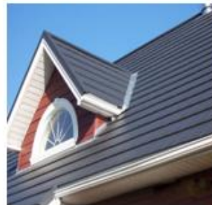
toiture en ardoise
