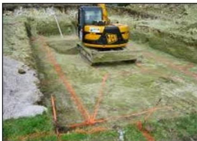
Figure 2.10 : Fouille en pleine masse
