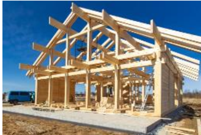
Figure I.13 : Structure en bois
