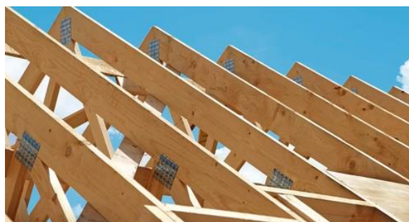
Figure 4.3 : Charpente industrielle (fermette)
