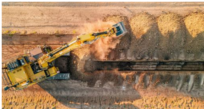
Figure. 2.1 : Travaux de déblaiement
