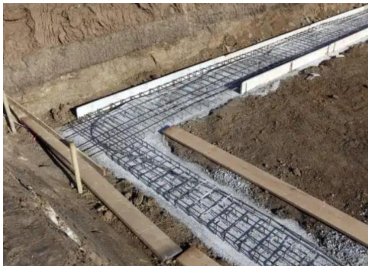
Figure 3.8 : Réalisation d'une semelle filante
