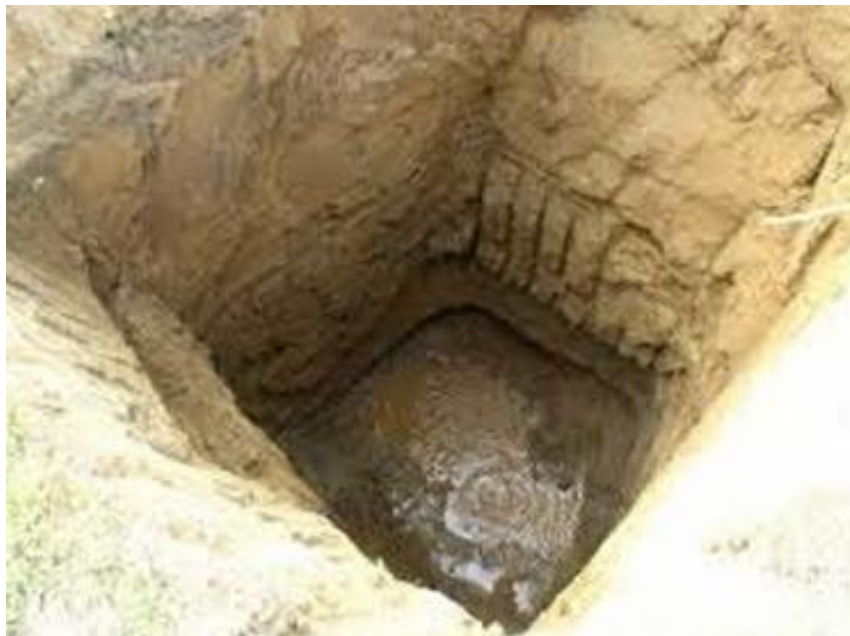
Figure 2.12 : Fouille en puits
