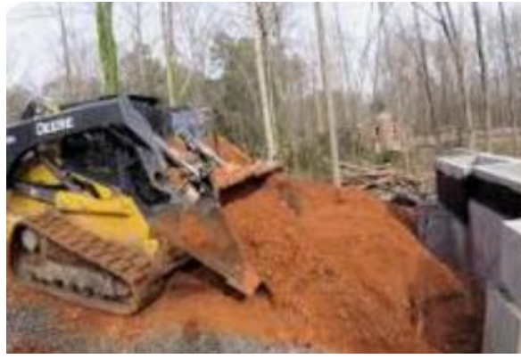
Figure. 2.2 : Travaux de remblaiement
