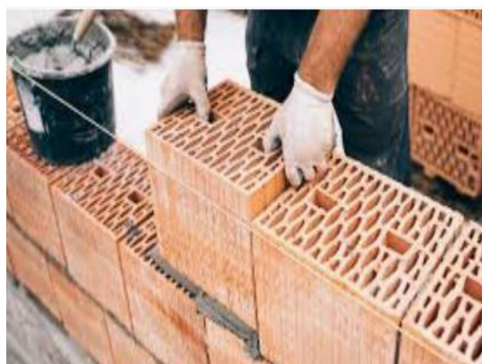
Figure I.10 : Structure en maçonnerie
