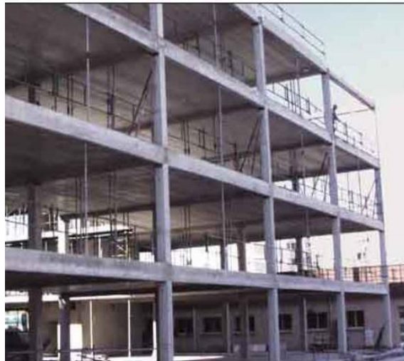
Figure I.11 : Structure en béton armé
