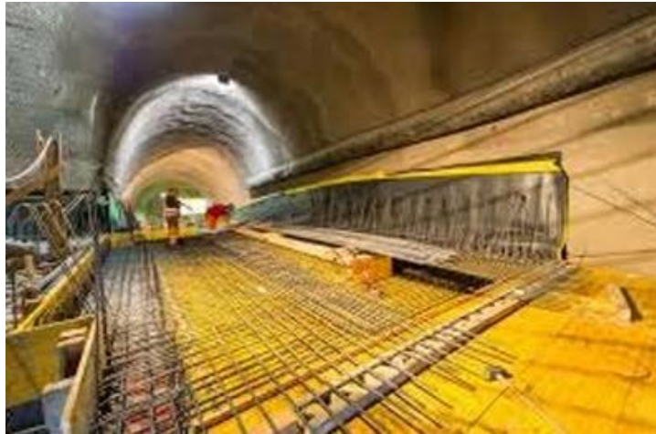
Figure 2.13 : Fouille en galerie
