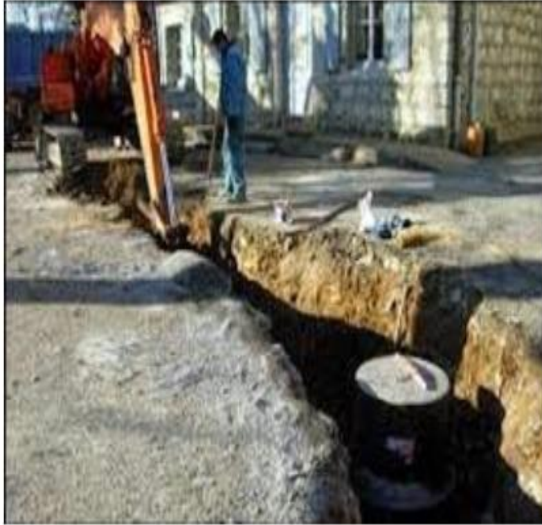
Figure 2.11 : Fouille en tranchée
