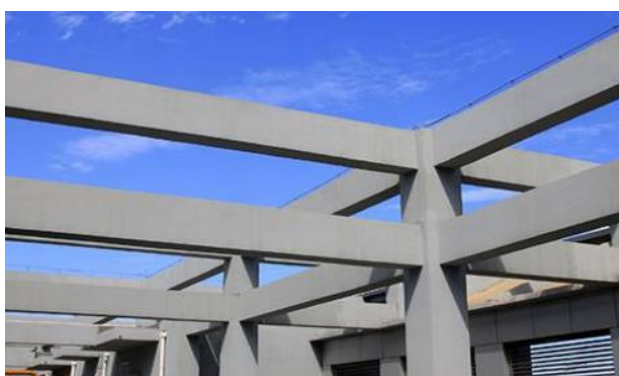
Figure 4.4 : Charpente en béton armé
