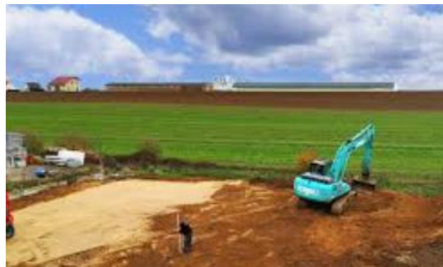
Figure 2.5 : Décapage des terres
