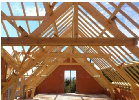
Figure 4.2 : Charpente traditionnelle en bois massif
