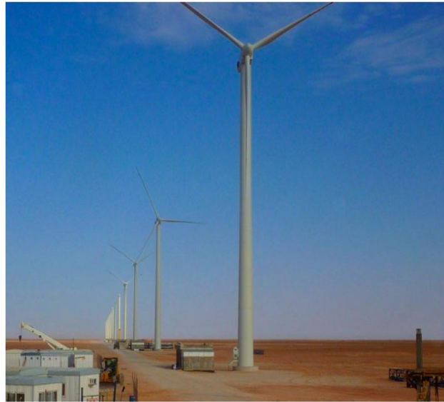
Figure I. 7 : Parc éolien à Kabertene d'Adrar [Wan-18].
