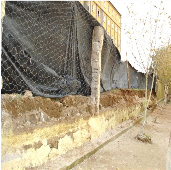
Figure 3.20. Mur de clôture en parpaing réalisé comme mur de soutènement [18]
