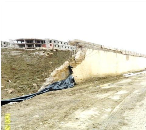
Figure 3.16. Effondrement du mur [18]
