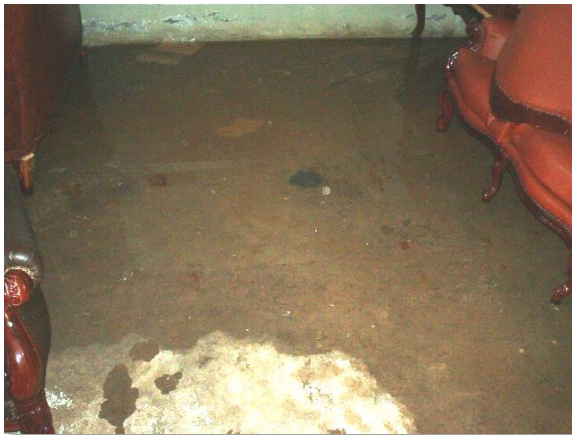
Figure 3.24. Infiltration des eaux pluviales [17]
