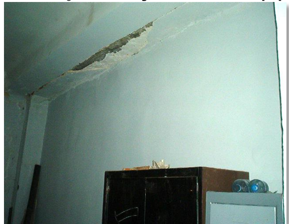
Figure 3.25. Dégradation des enduits [17]
