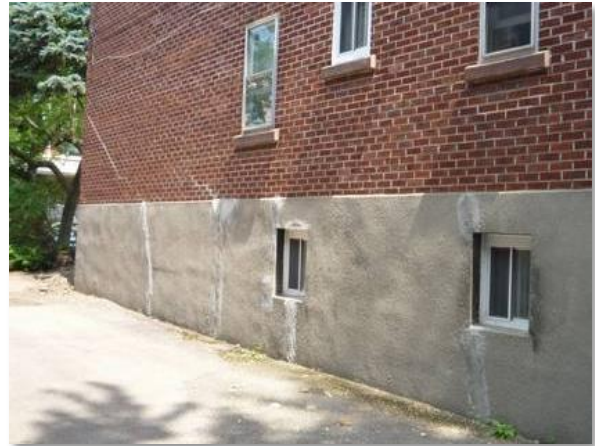
Figure 2.11. Tassement et fissurations liés à la sécheresse [7]
