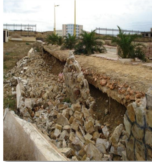
Figure 3.23. Pierres ne formant pas un bloc monolithe de maçonnerie [18]
