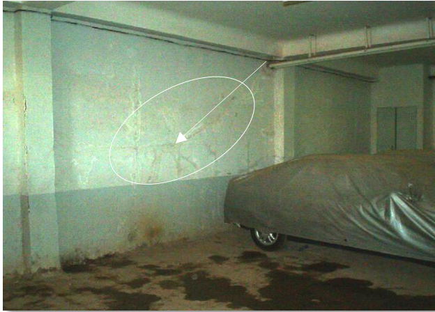
Figure 3.24. Infiltration des eaux pluviales [17]
