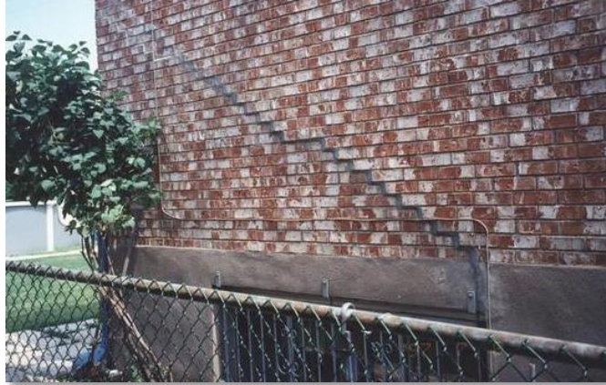
Figure 2.2. Fondations sur sol compressible [7]
