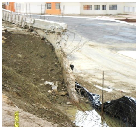
Figure 3.17. Epaisseur insuffisante [18]
