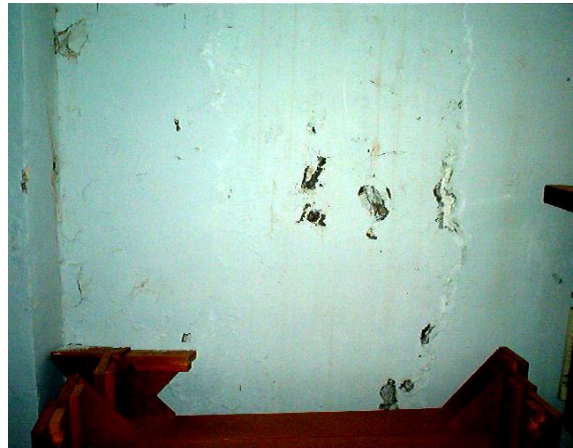
Figure 3.25. Dégradation des enduits [17]
