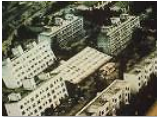
Figure 2.25. Liquéfaction du sol lors du séisme de Nigata au Japon 1967 [1]
