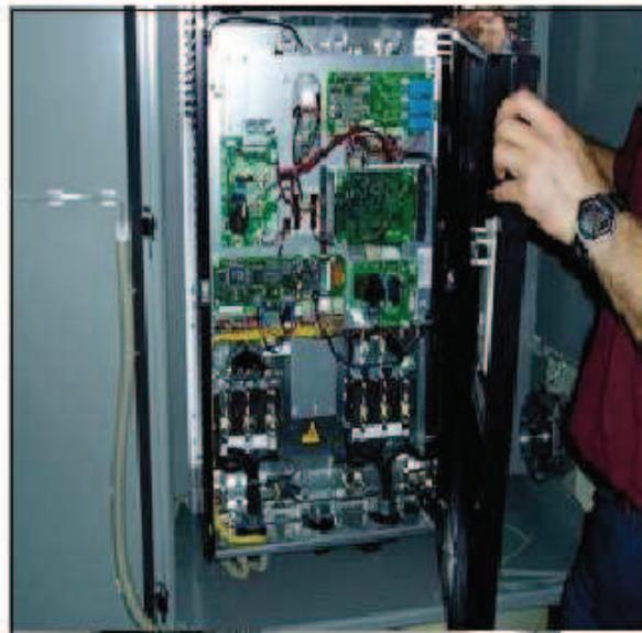
ABB- ACF-600 Air conditionné 45 KVA Drive
